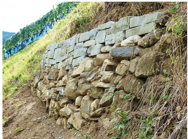
*Sanierte Trockenmauer (August 2018). Die alten Steine reichten nicht für die benötigte Mauerhöhe, die Ergänzung wurde mit neuen Sandsteinen sichtbar gemacht.*
