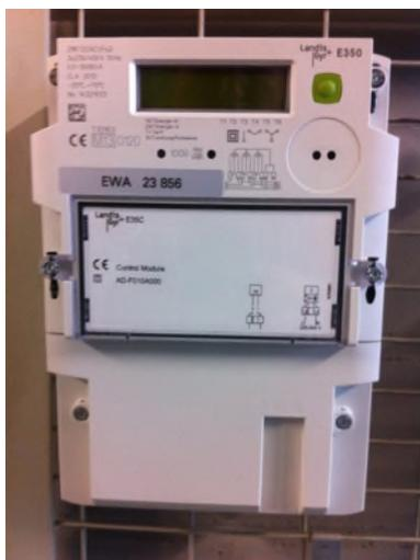
Durch einmaliges Drücken des grünen Knopfes erhält man das Zählwerk 1.8.1 und durch nochmaliges Drücken das Zählwerk 1.8.2.
