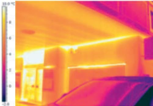
Die Deckenuntersicht beim Rathaus-Eingang weist über die gesamte Fläche Wärmeverluste auf. Die Wärmedämmung der Decke ist zu knapp. Der Übergang von der Decke zur Aussenwand zeichnet sich als grosse Wärmebrücke ab. An den Anschlüssen wird  $13,7^{\circ}\text{C}$  gemessen.
