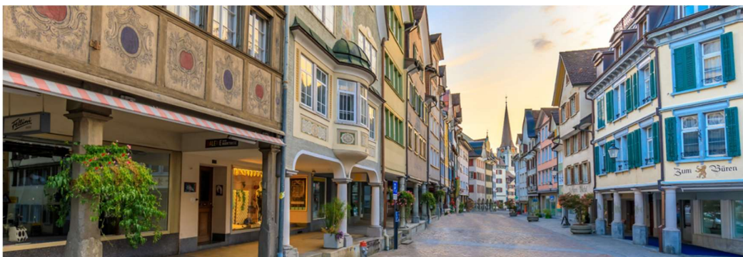
Abbildung 6: Altstätter Altstadt, Marktasse (Foto Stadt Altstätten)
